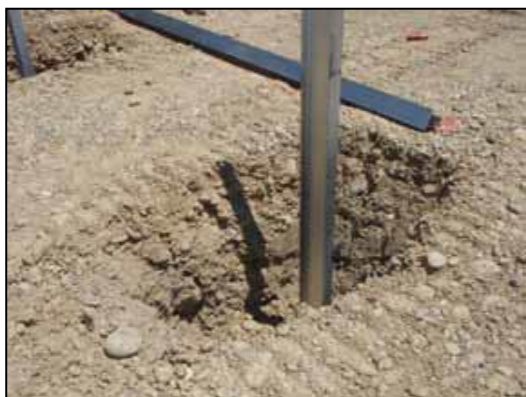
Figure 27 : Types de fondation - pieux battus (Source : Guide MEDDTL 2011 – NCA, 2015)
