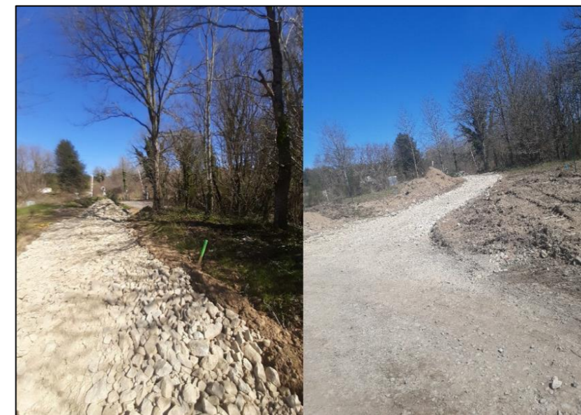
Figure 31 : Mise en place des pistes lors d'un chantier photovoltaïque (Source : TECHNIQUE SOLAIRE)
